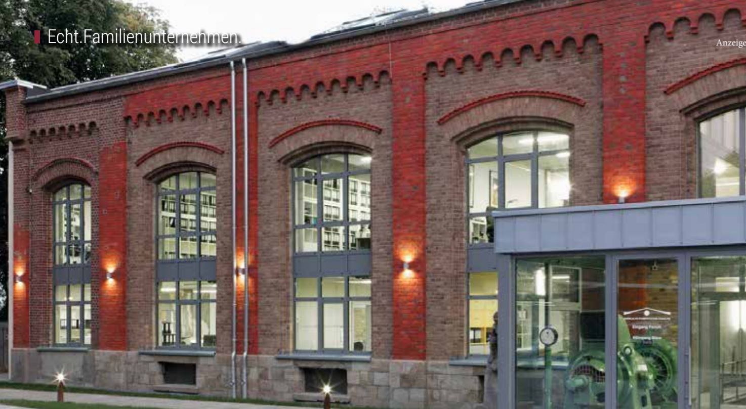
Die Alte Pumpstation in Haan ist zu einem echten Hingucker geworden.
